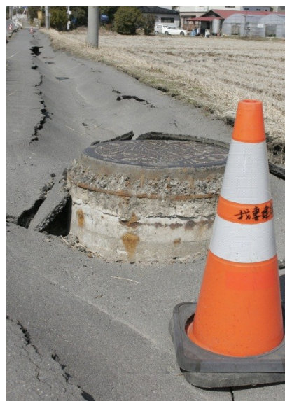
<写真左：路盤面の崩壊 大崎市松山伊場野付近>
